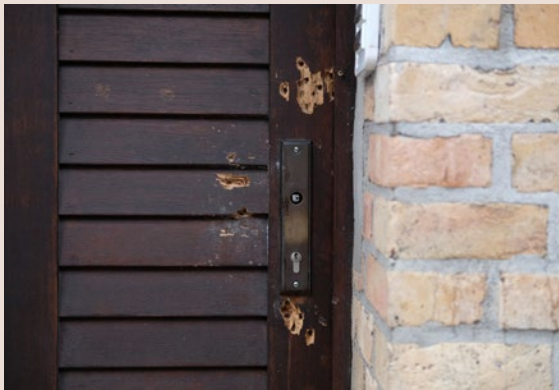
Einschusslöcher in der Tür zur Synagoge in Halle
