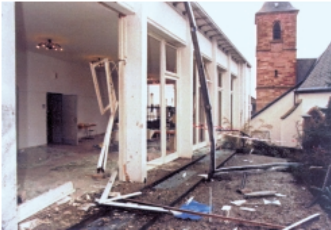
Sprengstoffanschlag auf die Räume der Wehrmachtsausstellung in Saarbrücken am 09.03.99 (↷ 2).
