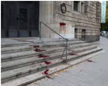
Sachbeschädigung „Altes Polizeihaus“
