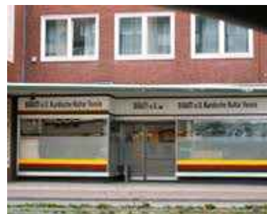
Gebäude des „Birati e.V.“ in Bremen
