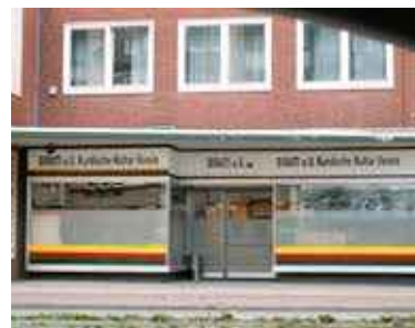
Gebäude des „Birati e.V.“ in Bremen
