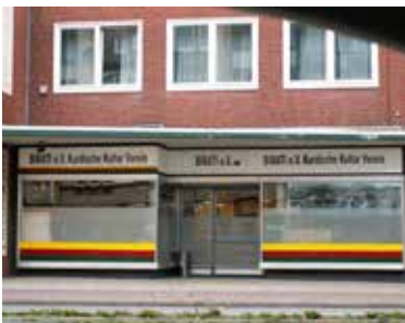
Gebäude des „Birati e.V.“ in Bremen
