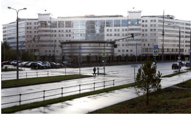
Gebäude des GRU
